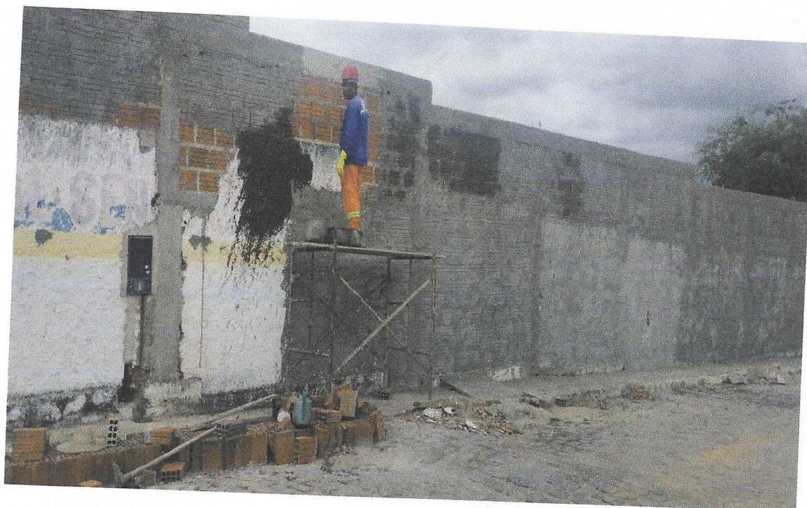
FOTO 08 EXECUÇÃO DE ALVENARIA E CHAPISCO DO MURO FRONTAL
