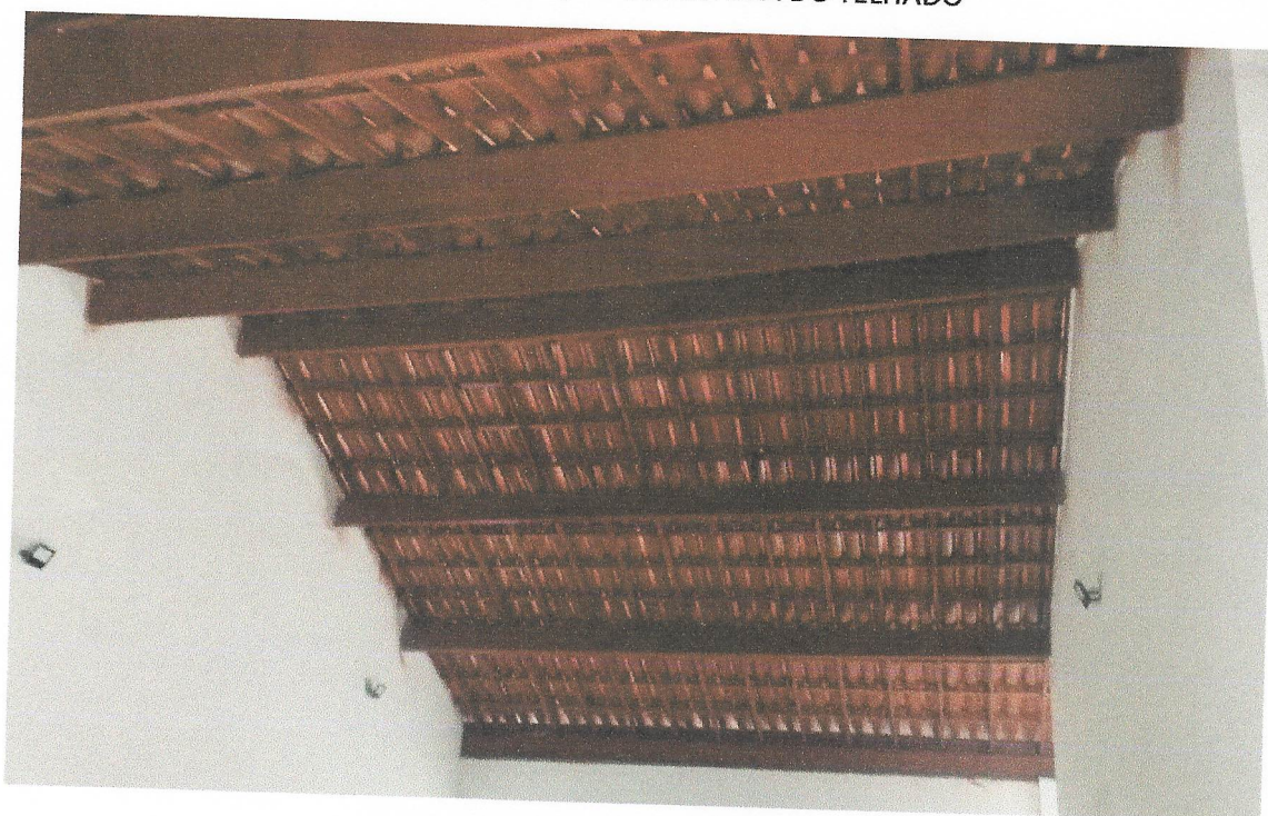
FOTO 24 EXECUÇÃO DE PINTURA DO TELHADO
