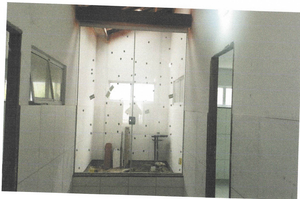
FOTO 18 INSTALAÇÃO DE VIDRO DO JARDIM DE INVERNO
