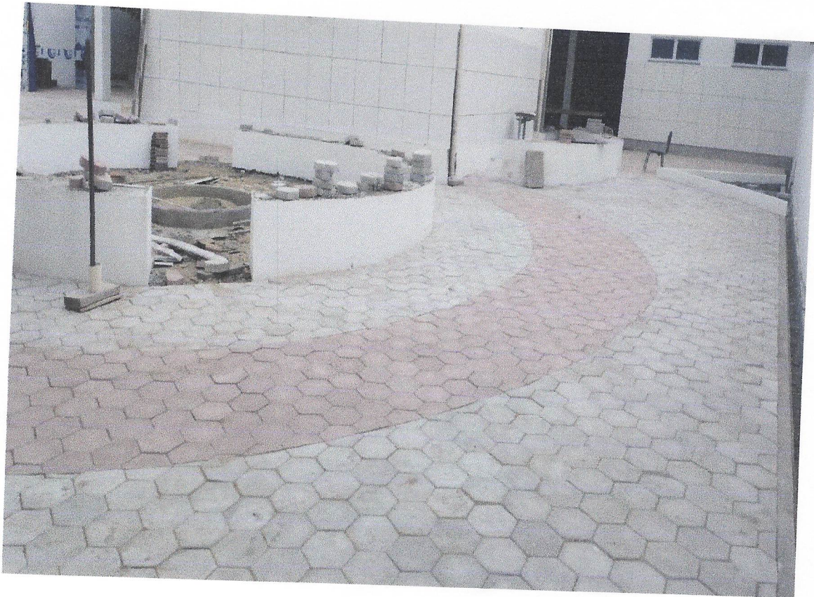
FOTO 02 EXECUÇÃO DE PISO INTERTRAVADO
