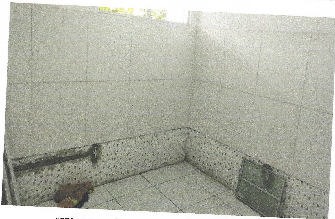
FOTO 15 EXECUÇÃO DE REVESTIMENTO CERAMICO NA PAREDE
