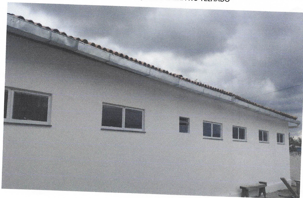
FOTO 12 INSTALAÇÃO DE CALHA NO TELHADO
