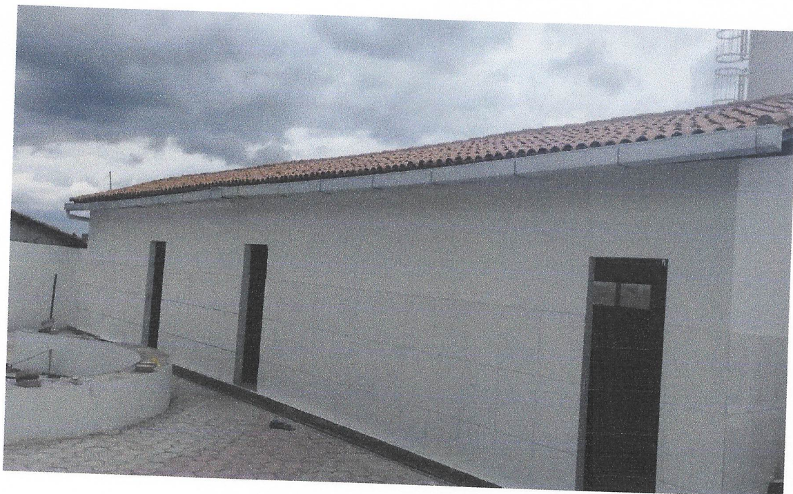
FOTO 11 INSTALAÇÃO DE CALHA NO TELHADO
