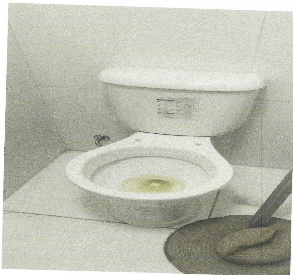
FOTO 14 INSTALAÇÃO DE VASO SANITARIO
