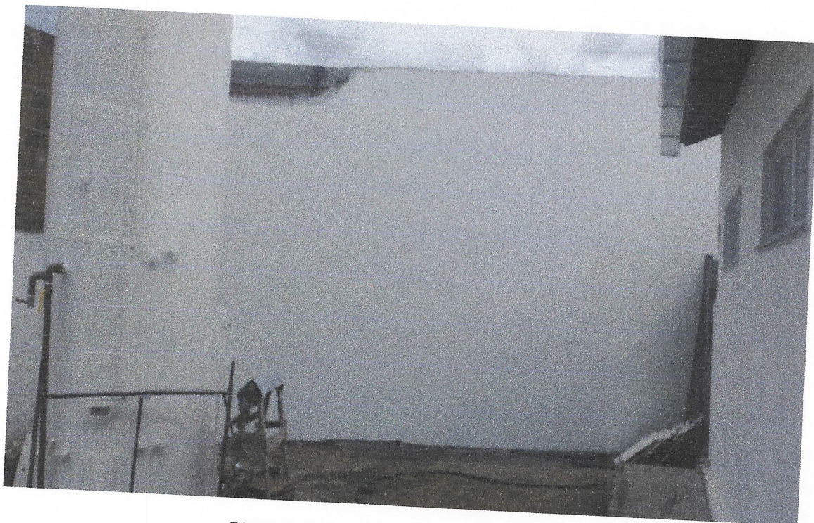
FOTO 05 EXECUÇÃO DE MASSA ACRILICA
