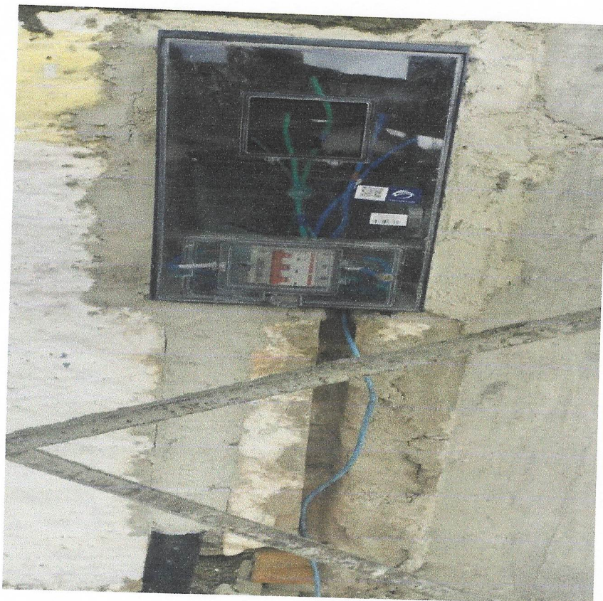
FOTO 22 INSTALAÇÃO DO MEDIDOR DE ENERGIA
