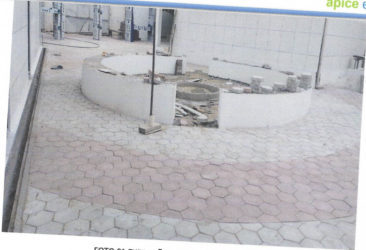
FOTO 01 EXECUÇÃO DE PISO INTERTRAVADO
