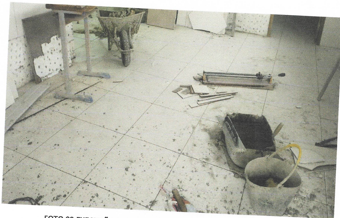
FOTO 09 EXECUÇÃO DE PISO CERAMICO NA SALA DE ADMINISTRAÇÃO
