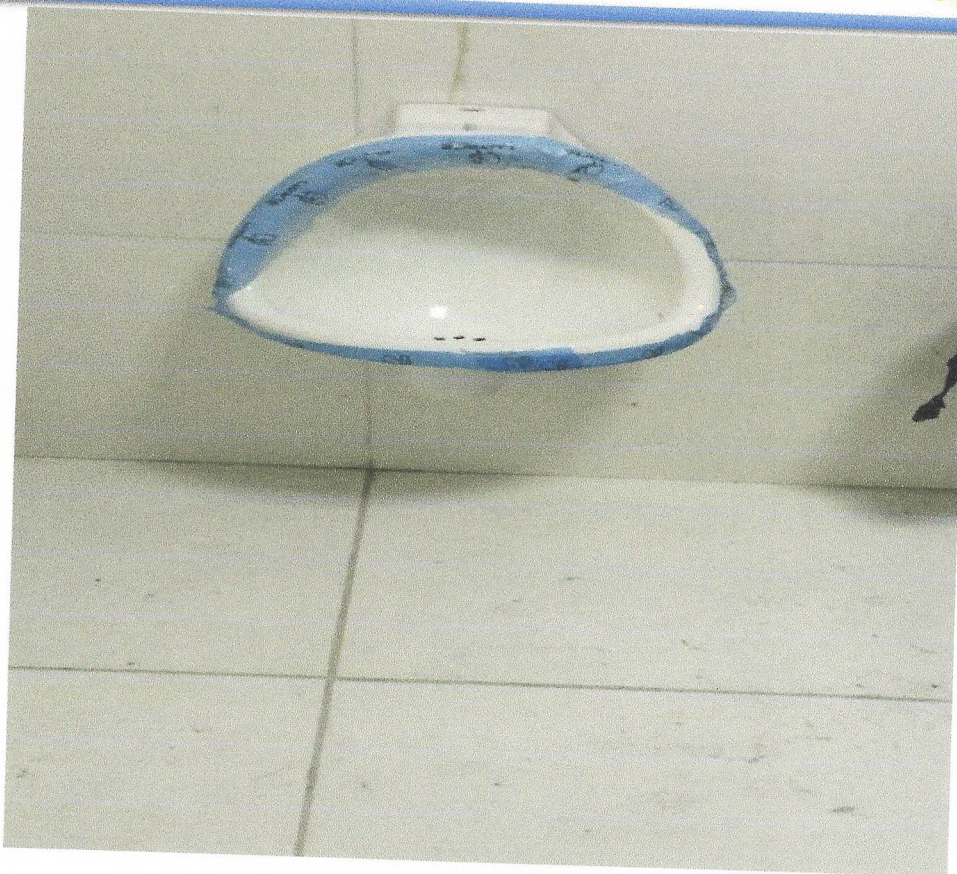
FOTO 13 INSTALAÇÃO DE MICTORIO
