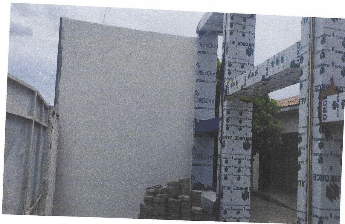
FOTO 06 EXECUÇÃO DE MASSA ACRILICA
