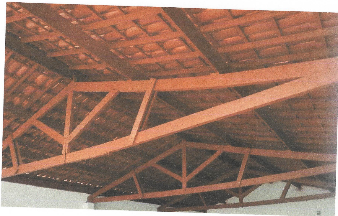
FOTO 23 EXECUÇÃO DE PINTURA DO TELHADO
