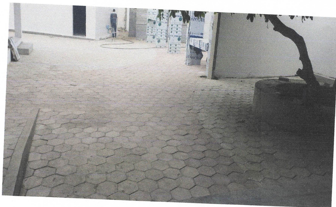
FOTO 04 EXECUÇÃO DE PISO INTERTRAVADO
