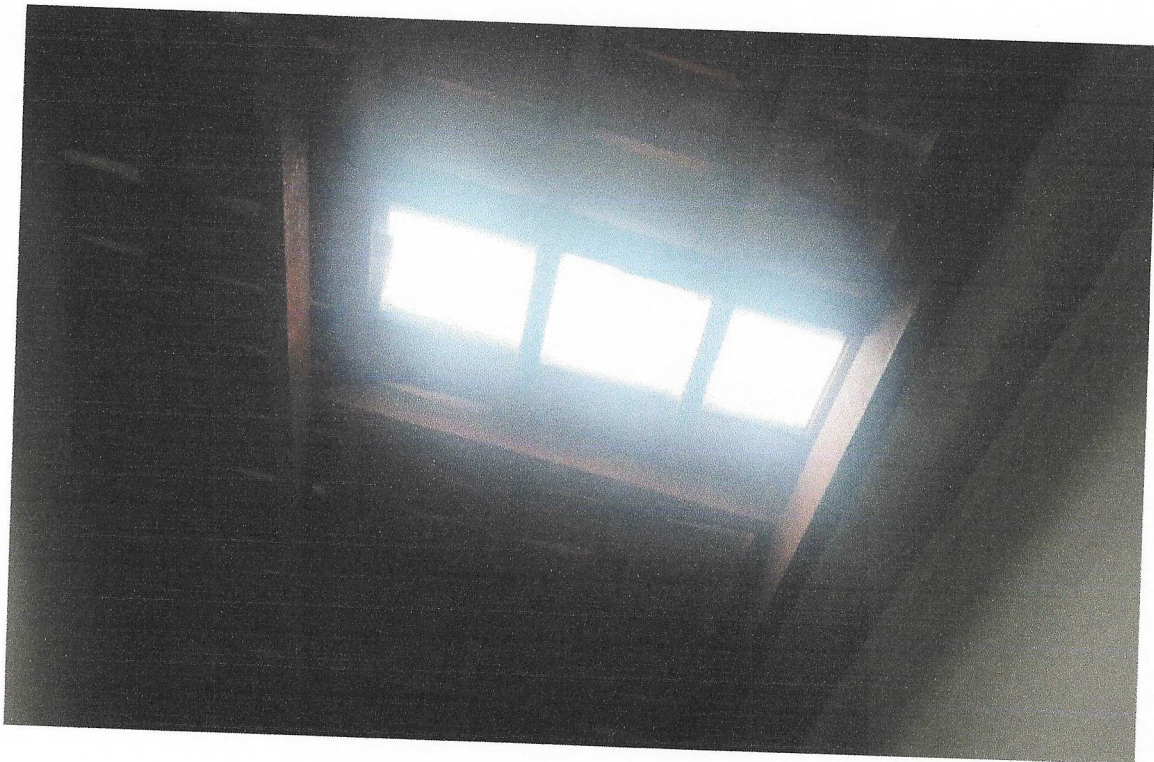
FOTO 21 INSTALAÇÃO DE TELHA DE VIDRO
