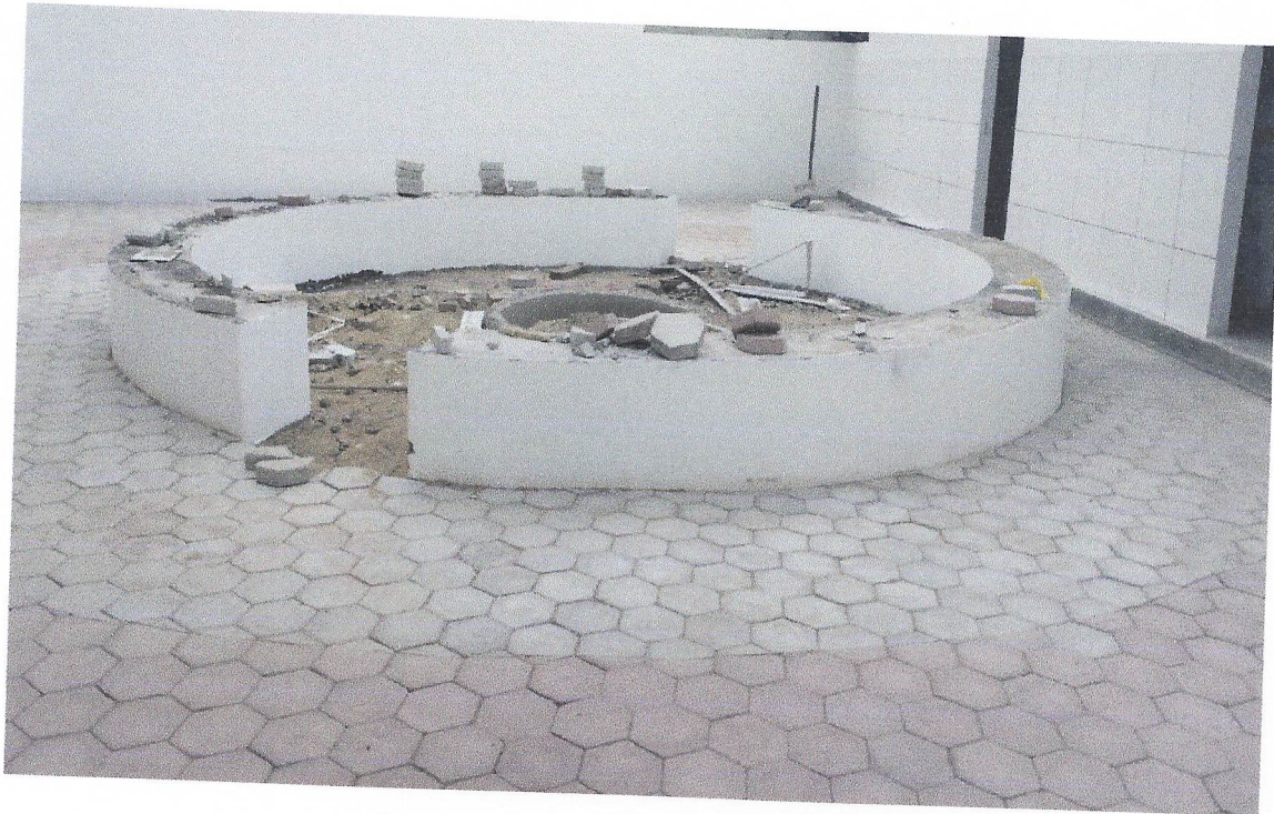
FOTO 19 EXECUÇÃO DE MASSA ACRILICA NOS BANCOS EXTERNOS
