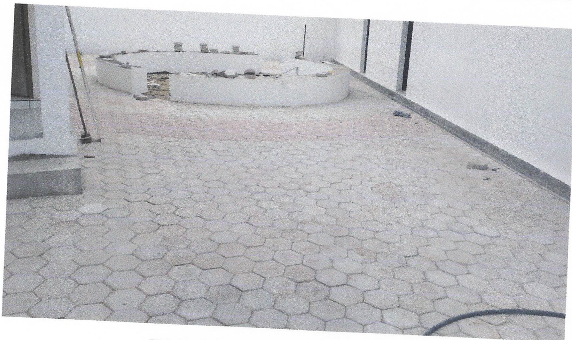
FOTO 03 EXECUÇÃO DE PISO INTERTRAVADO
