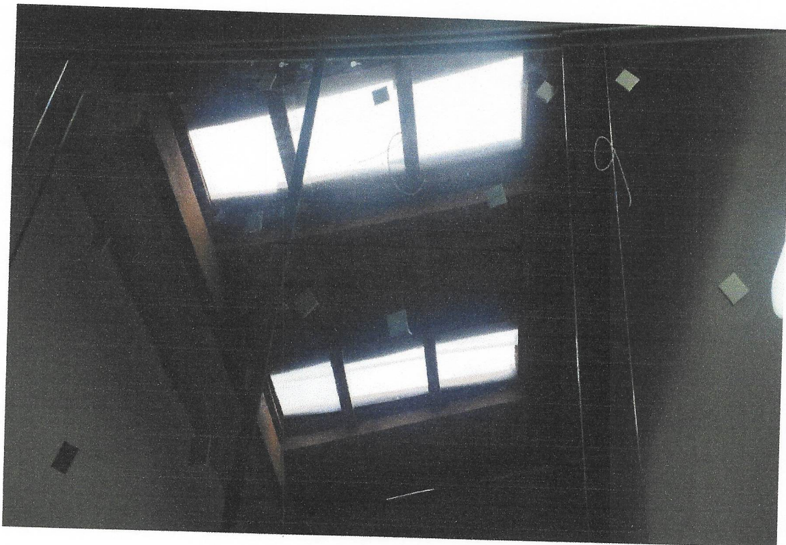
FOTO 20 INSTALAÇÃO DE TELHA DE VIDRO
